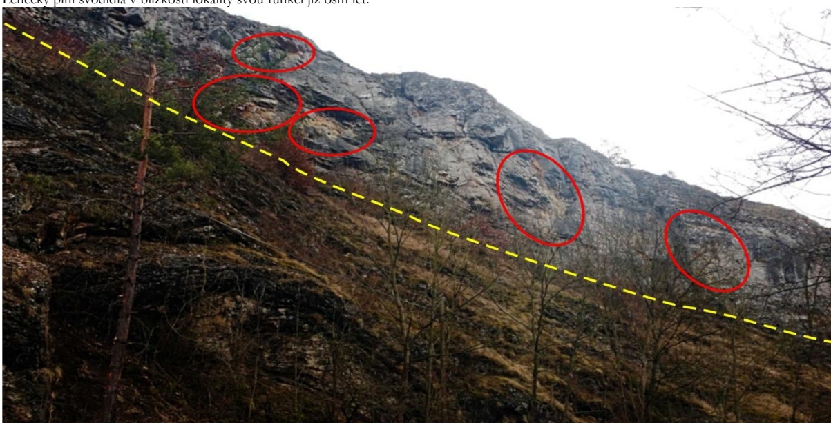
Foto 8 Dokumentační fotografie zachycuje části skalního svahu (červené elipsy), kde proběhlo jeho začištění prostřednictvím horolezecké techniky. Relativně zřetelně jsou vidět odlučné plochy, které mají světlejší barvu oproti svému okolí. Žlutou čárkovanou křivkou je označen litologický přechod mezi lochkovskými a sliveneckými vápenci vytvářejícími četné převisy.
