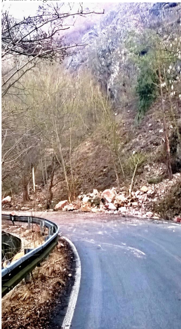
Foto 3a,b Snímky ukazují množství materiálu, které dne 18.2.2017 přibližně v 05:00 hod. zavalilo komunikaci Na Cikánce. Na žádost Policie ČR byla silnice protažena nakladačem pro její zprůjezdnění. Na snímku lze vidět několik bloků až metrových rozměrů. Odhadem se jednalo o cca 5 m 3 horninového materiálu. Vlevo pohled směrem k severu, vpravo pohled směrem k jihovýchodu (Foto Ing. Tomáš Lehečka 19.2.2017).
