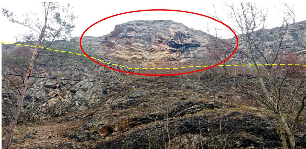
Foto 4 Panoramatický snímek dokumentuje odlučnou oblast části skalního masivu (červená elipsa), odkud se uvolnil horninový materiál. Zřetelně jsou vidět odlučné plochy, které mají jasnou oranžovo-růžovou barvu. Zároveň je dobře patrné litologické rozhraní lochkovských (níže) a sliveneckých vápenců (výše) – žlutá čárkovaná linie.
